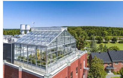
Serre du bâtiment Johnson récemment rénovée
